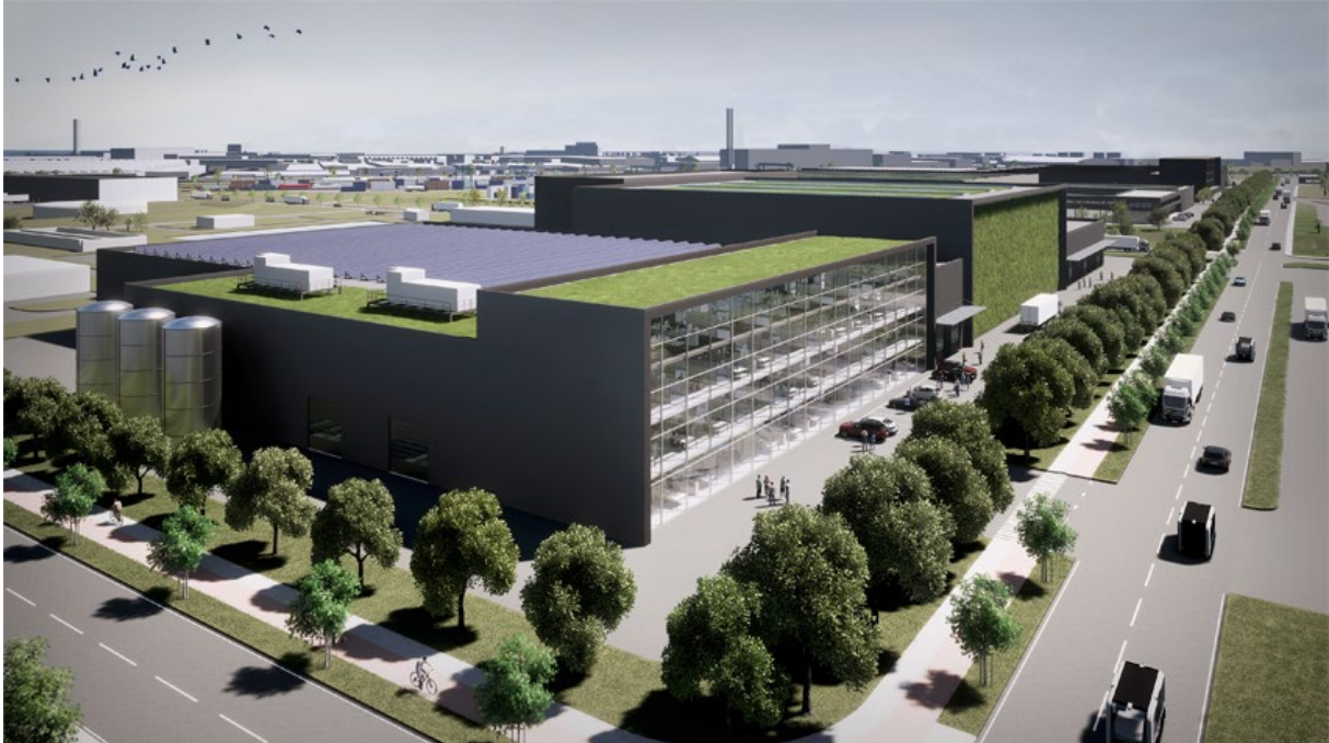
Bild: HGK / Dr. Schönheit & Partner Das Productive Village verbindet auf einer Fläche unterschiedliche Nutzungsanforderungen, von Büro über Laborflächen und Produktion bis zur angeschlossenen Logistik.
