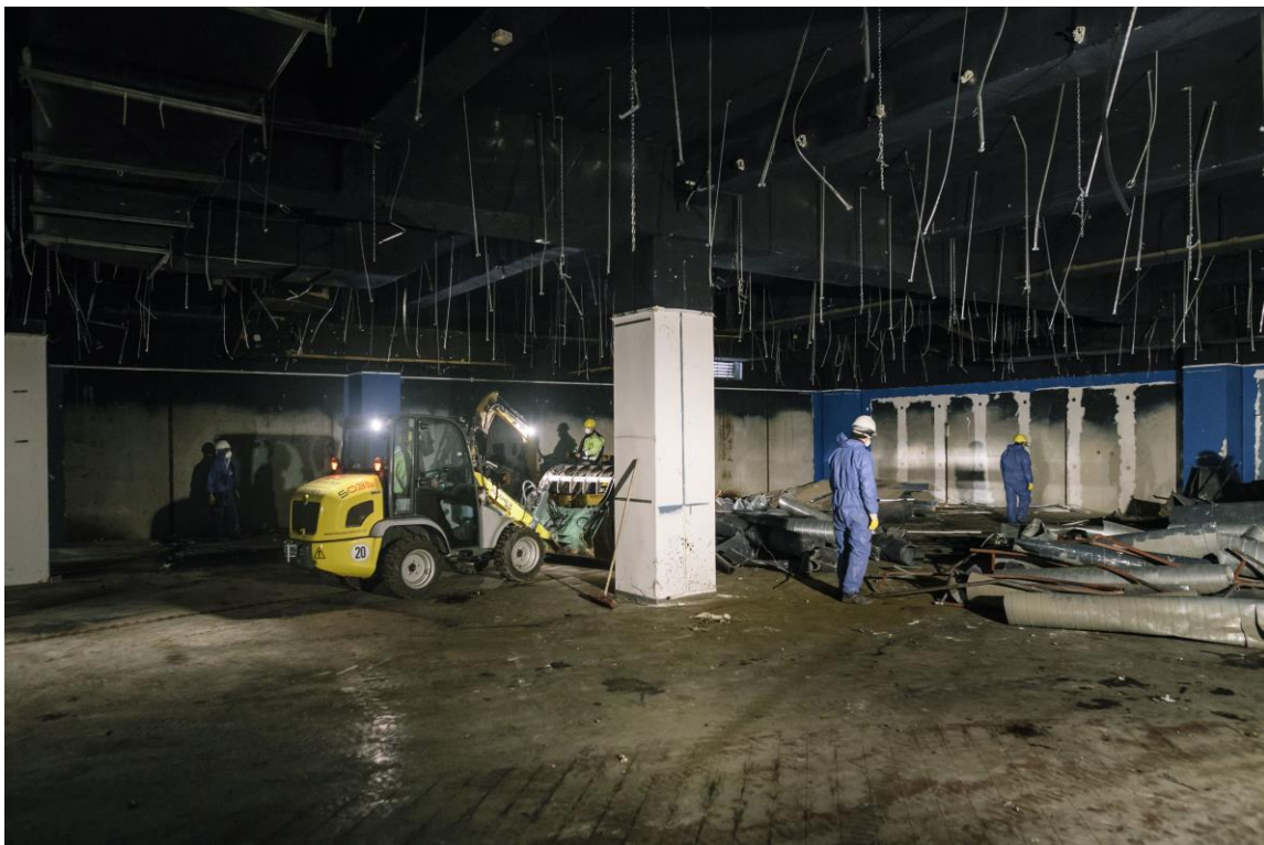
Die Entrümpelung im ehemaligen Hertie-Gebäude ist in vollem Gange
